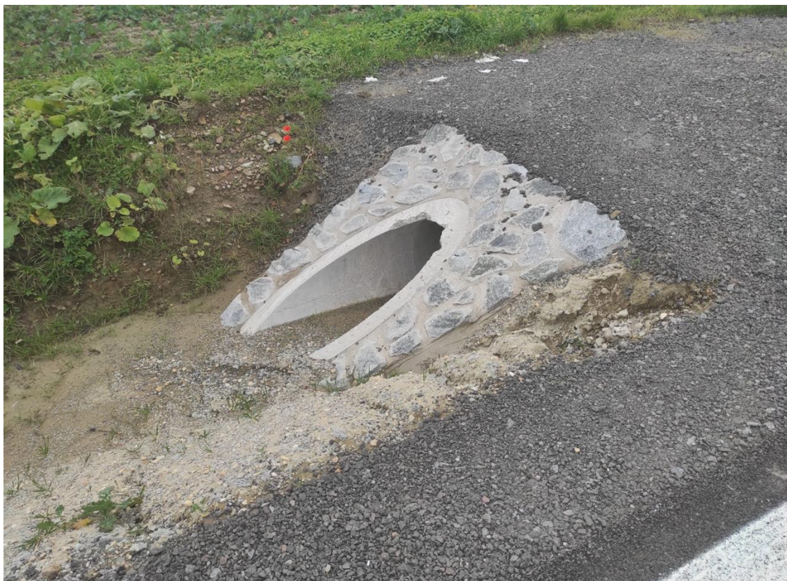
Obrázek 3 Příklad provedení vtoku a výtoku propustku se šikmým čelem pod hospodářským sjezdem
